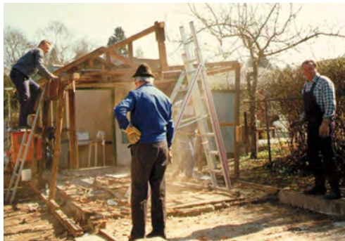
Vom Abbruch der alten Kantine ...
