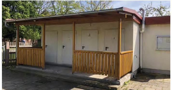
Die neue Toilettenanlage
