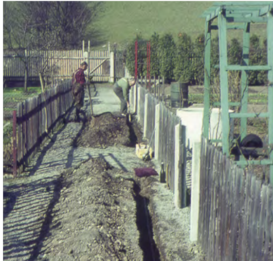
Bau der Wasserleitung
